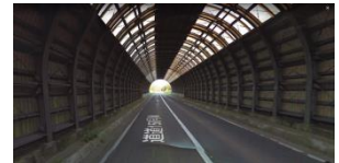
シェルター工の例(道道150号摩周湖中標津線) Googleストリートビューより
