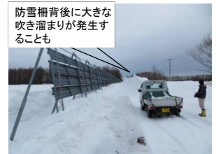
道道975号開陽川北線に設置された防雪柵の例 このように防雪柵の設置はスポット的で、効果は限定的
